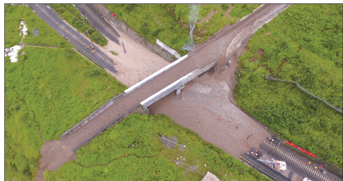
7月30日21时许,成昆铁路阿寨站至白果站间发生泥石流灾害,上方方泥石流掩埋铁道
