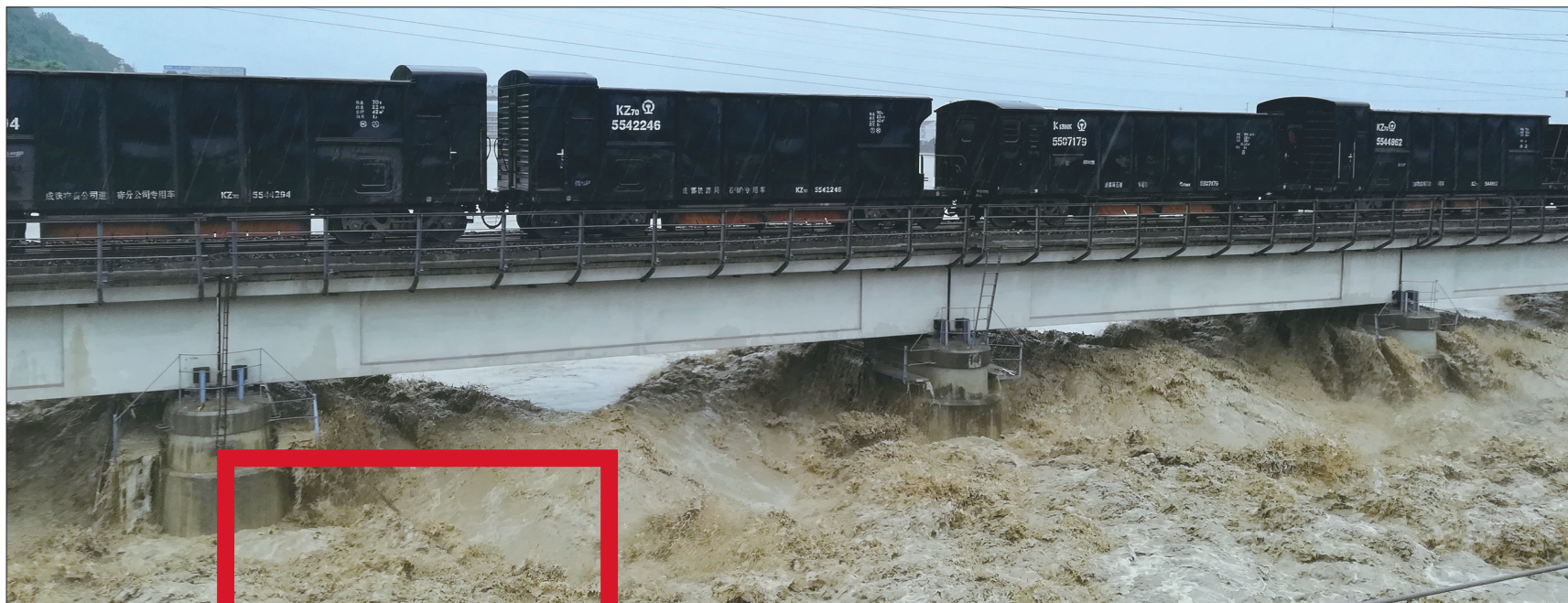
货物列车对涪江铁路大桥进行压梁
