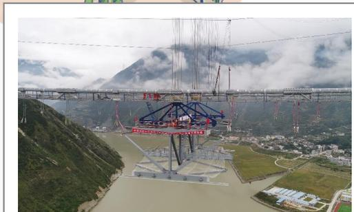
兴康特大桥首节钢桁梁吊装,工人在高空施工 (华西都市报-封面新闻记者 杨涛)
