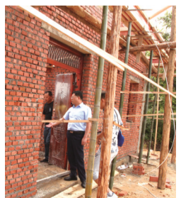
张启程查看猫猫岭村文化室建设项目。
