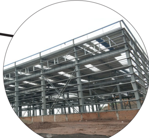
四川华川基业建设集团有限公司车间建设现场。
