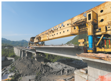
13日,成贵铁路兴文段最后一孔梁成功架设。
