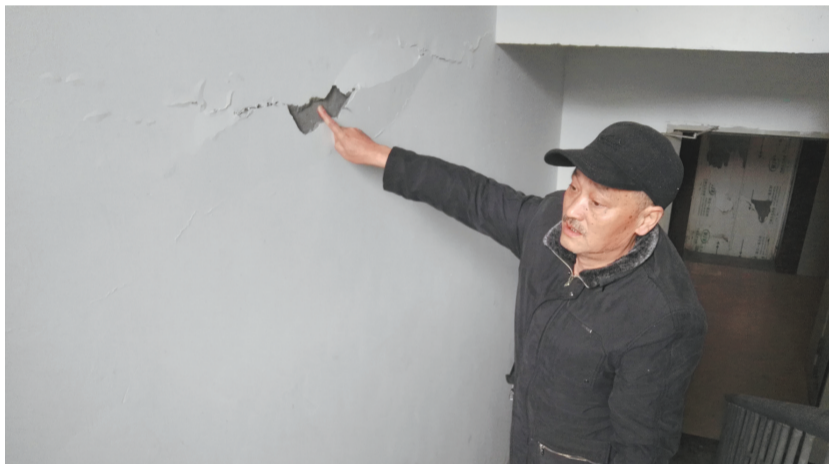
业主刘先生指着墙面水泥面脱落处。
