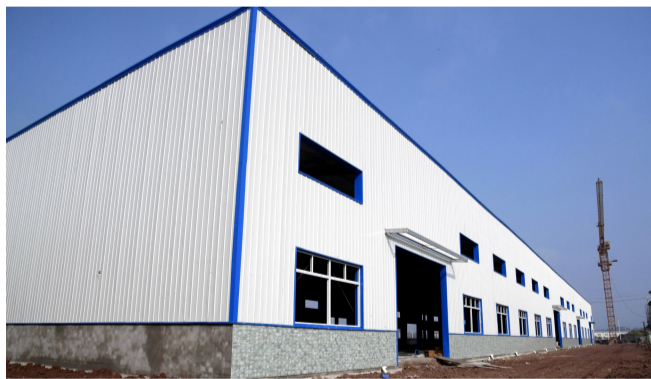
即将竣工投产的鑫冠诚电子科技有限公司。
