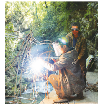
巴山大峡谷桃溪谷施工现场。
