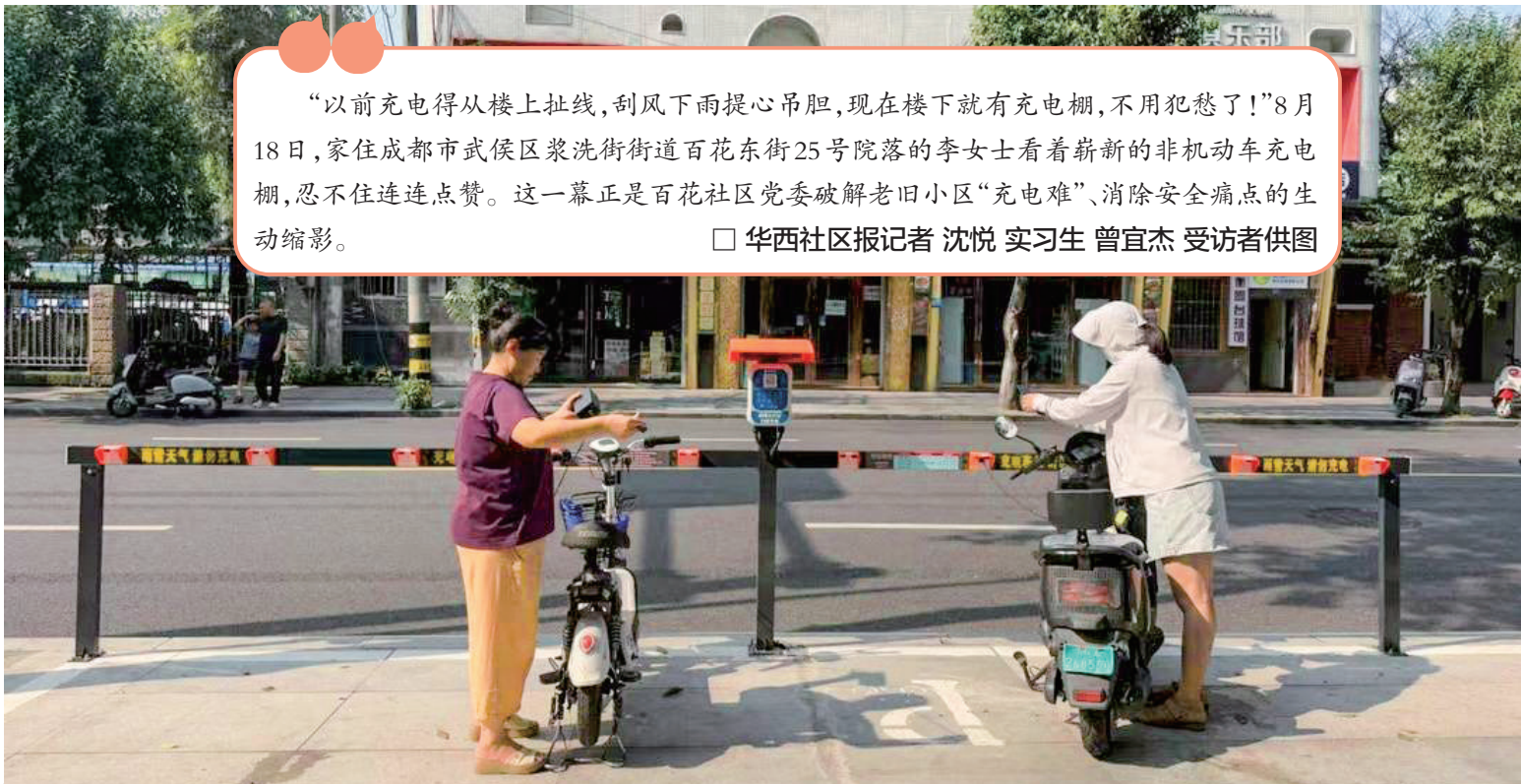
6处充电点位全面投入使用。
