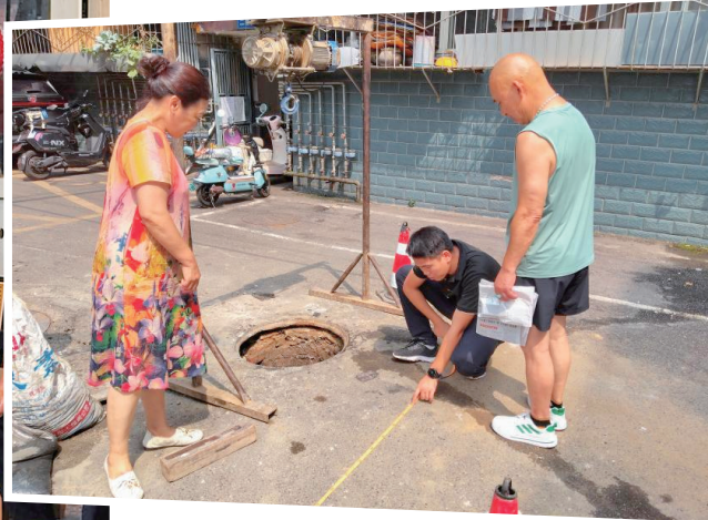
专项监督小组全程跟进工程施工全流程。
