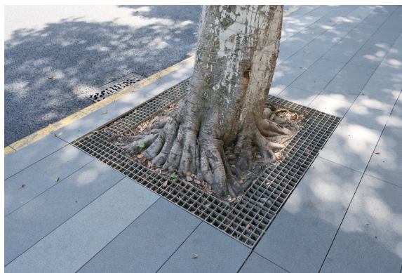
莲桂西路重新砌筑后的树池。
