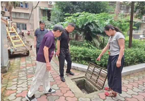
工作人员对小区排水管网展开排查。
