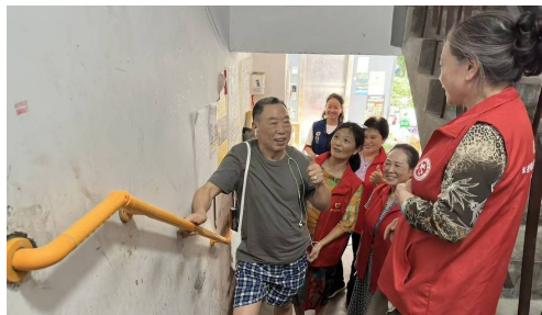
一楼入口处装上了崭新的扶手。
