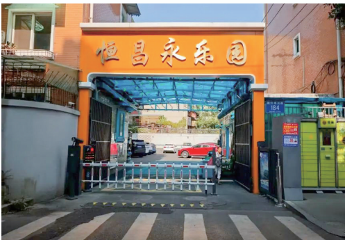
扎实推进老旧小区改造。
