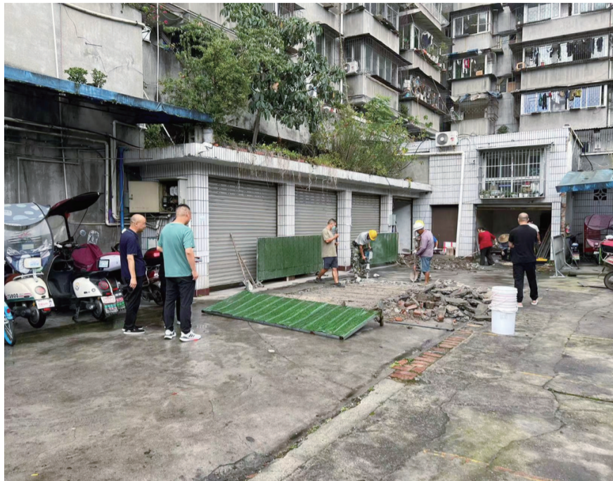
确定化粪池位置。
