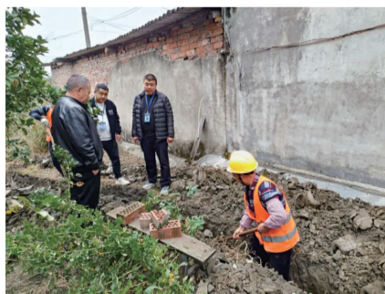
清风专员查看社区供水项目实施情况。
