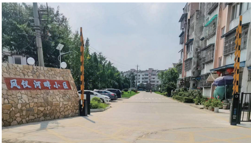
小区大门处重新铺装路面,安装了道闸。
