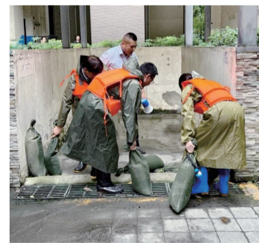
用沙袋堵住易进水口。
