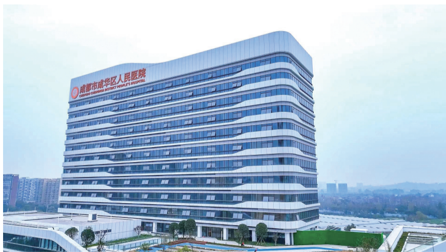
成华区人民医院新院区进入主体竣工验收阶段。
