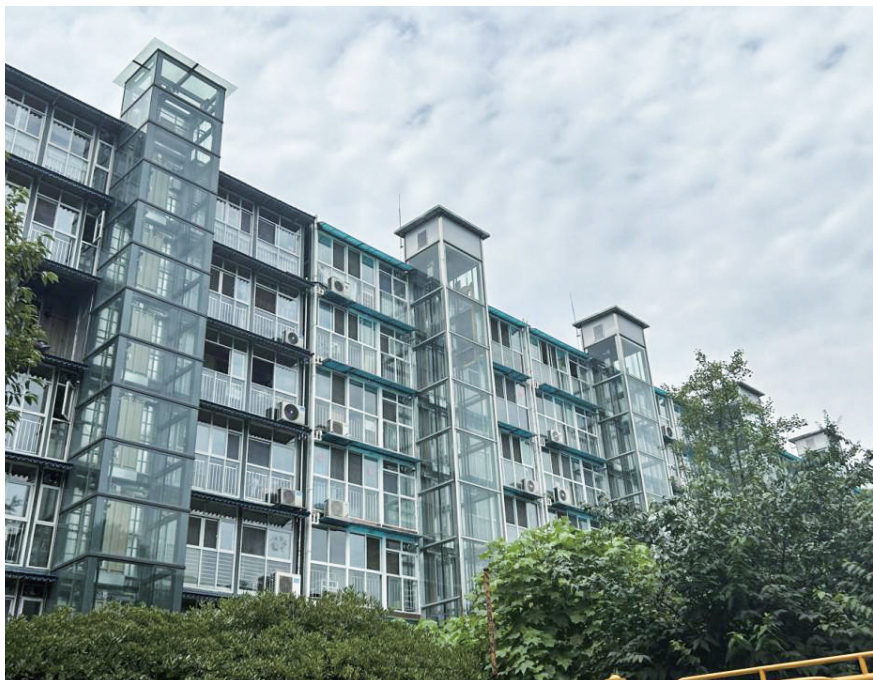
成飞800小区观光式电梯整洁美观。青羊区既有住宅自主增设电梯目前已累计施工942台。
