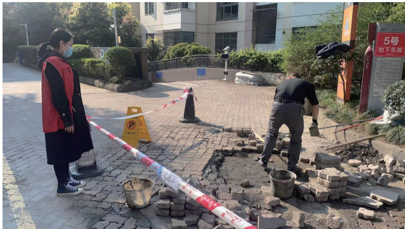
对问题路面进行翻新处理。
