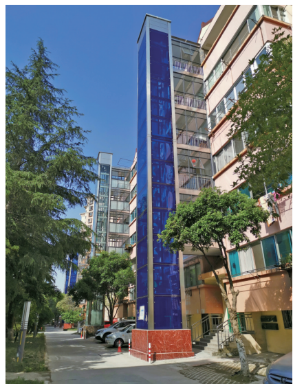
小区加装电梯方便了居民上下楼。
