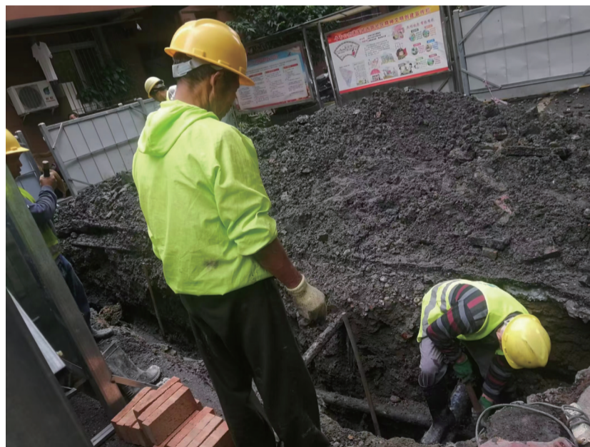
更换院落老化管道。
