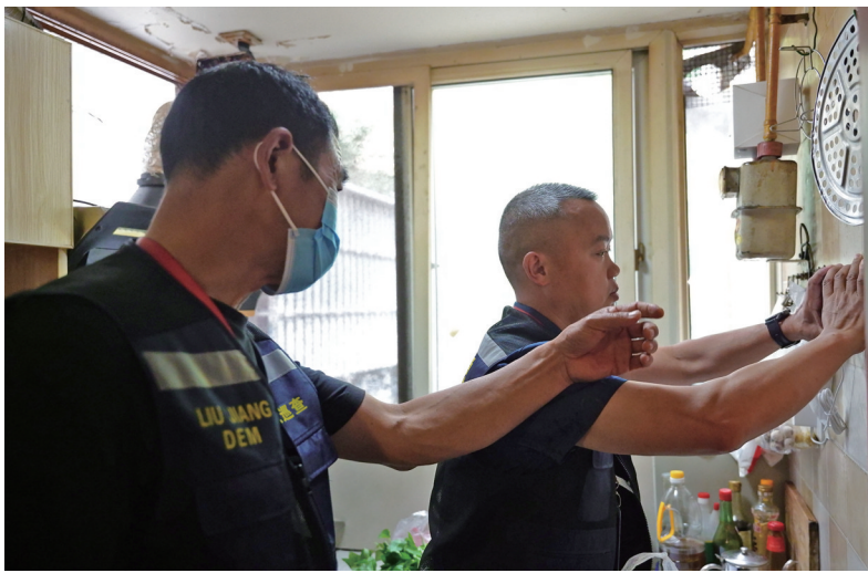
有关人员在居民家安装燃气报警装置。
