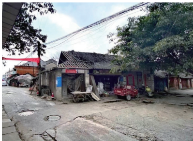
临街店铺拆掉前的“鹅颈项”。
