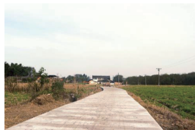
修建好的公路。
