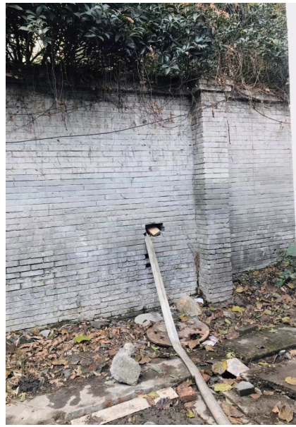
抽水管“穿墙”而出。
