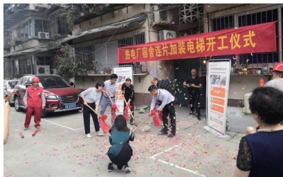
居民们高兴地参与电梯加装开工仪式。
