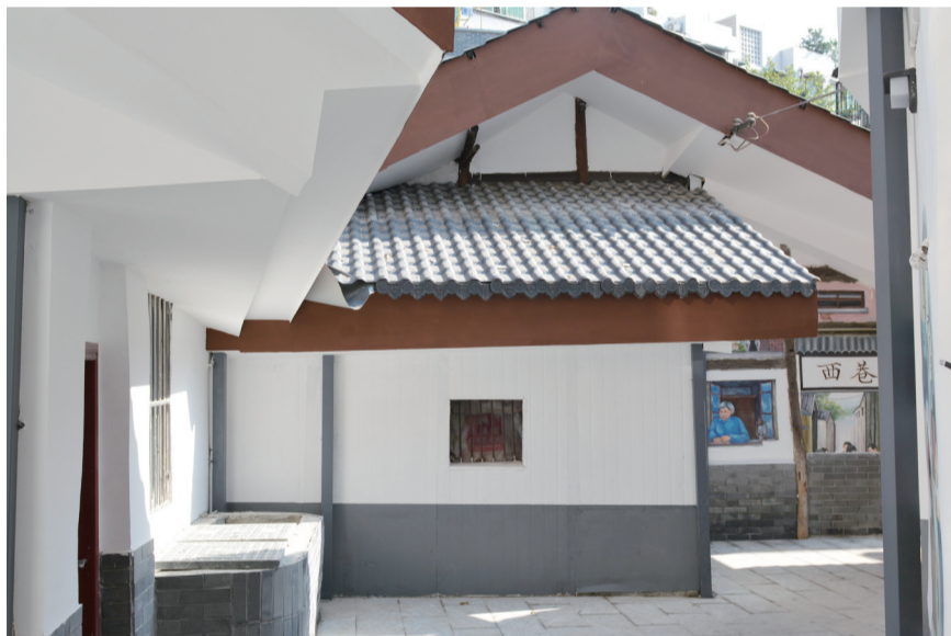
改造后的石灰巷面貌一新。
