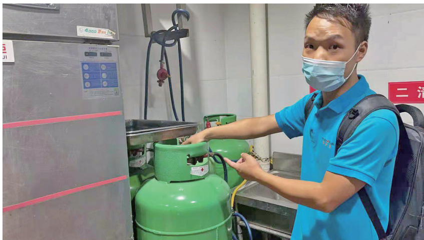
检查商铺安全用气情况。
