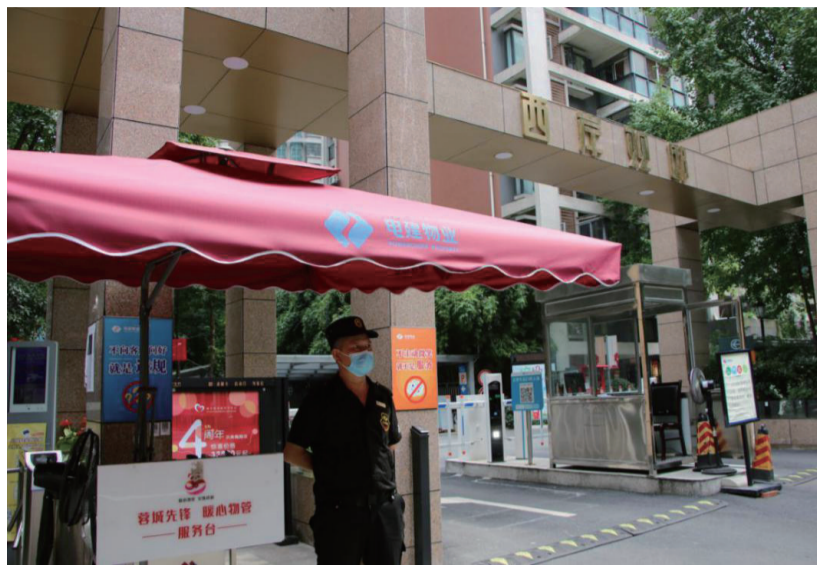
改造升级后的小区大门。
