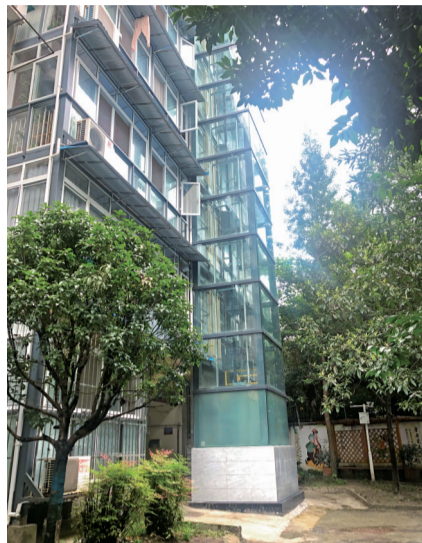
加装电梯方便了居民上下楼。
