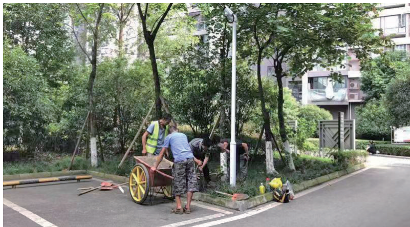
安装监控设备。
