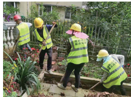
水管网改造中。
