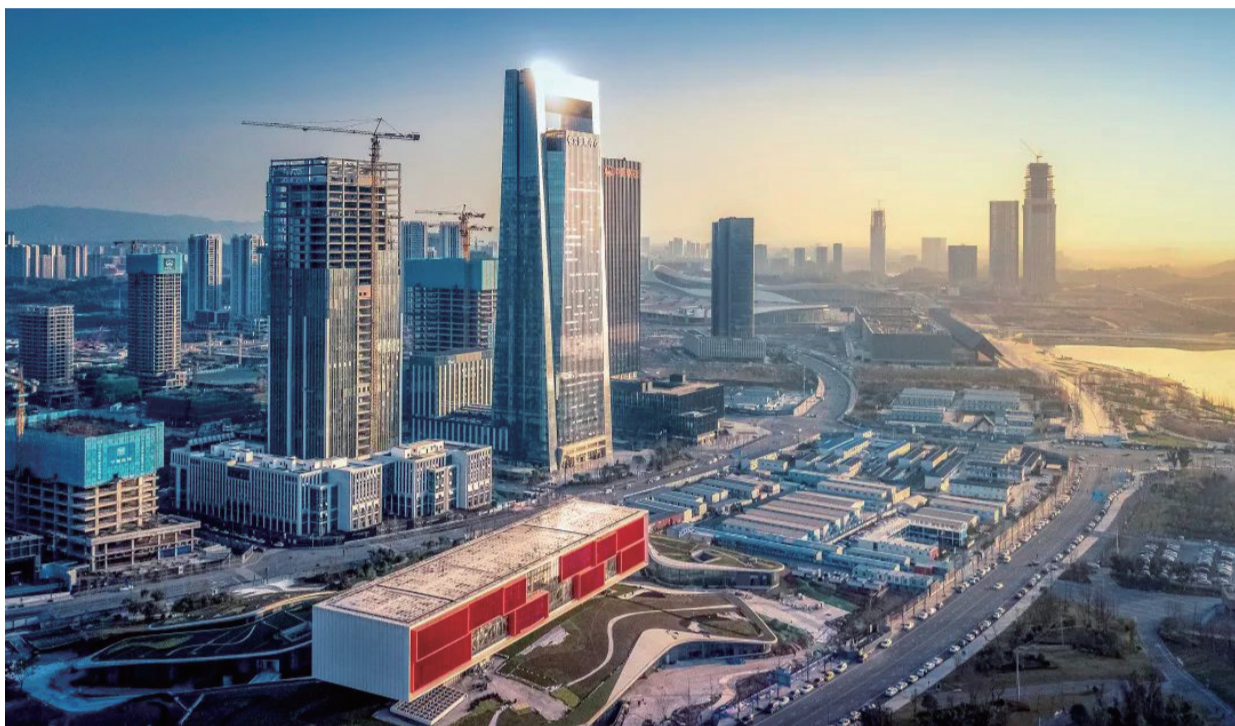
天府新区基础设施建设如火如荼。
