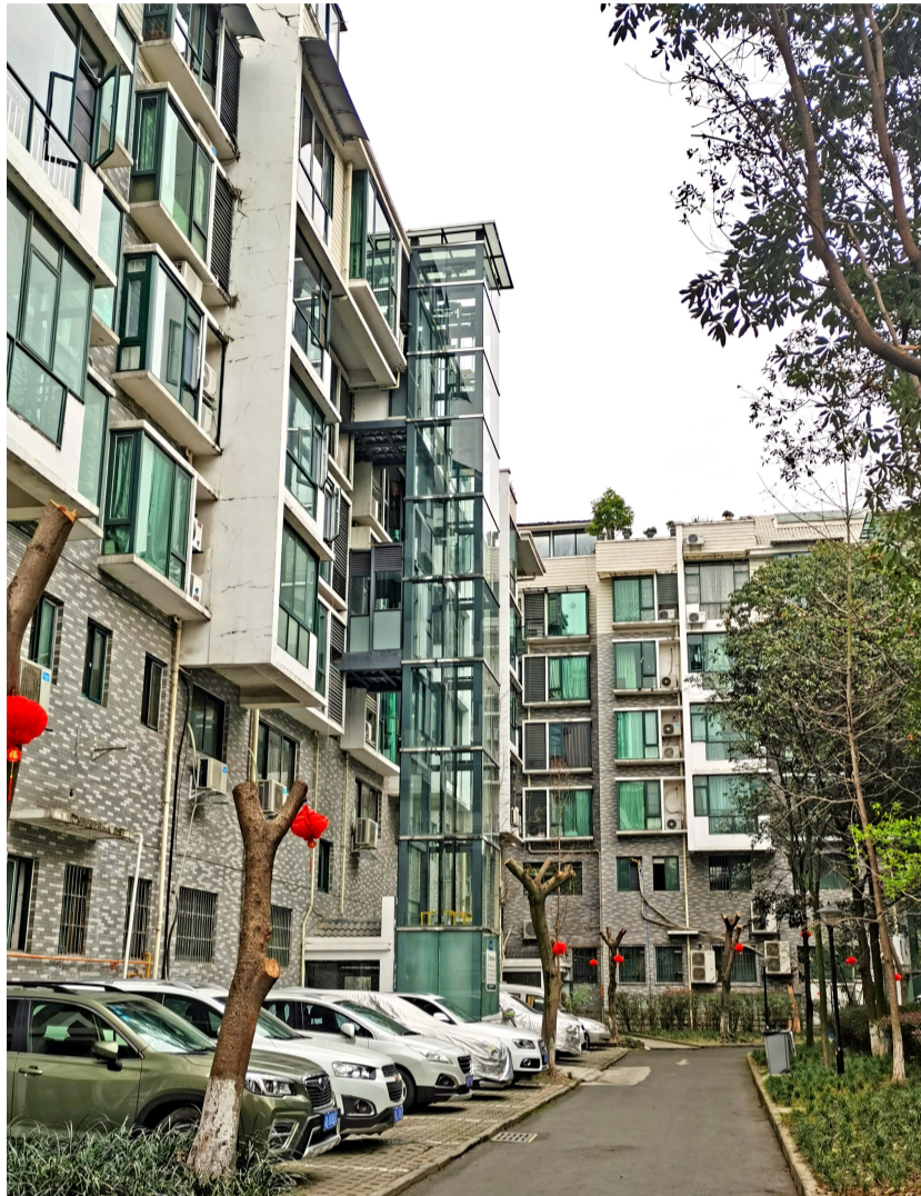
华阳亲水湾小区自主增设的电梯方便了居民上下楼。
