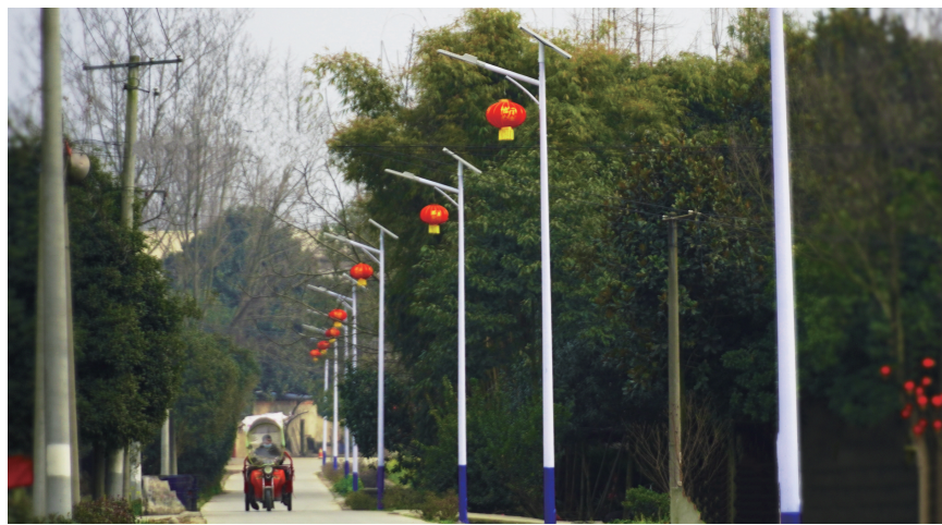
安装好的路灯。
