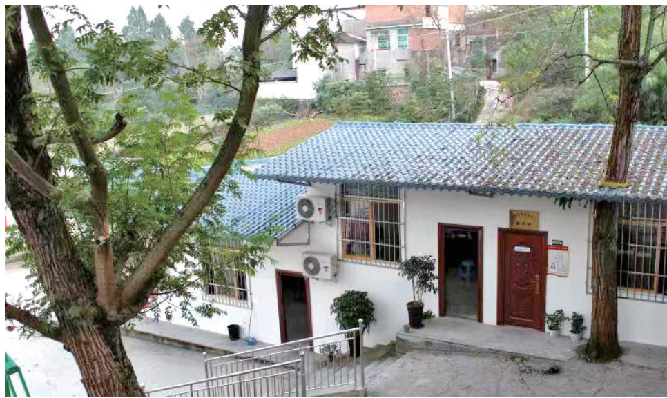
房屋外表焕然一新。
