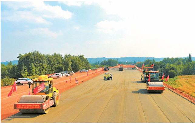
成都三绕西段进入路面铺装阶段。
