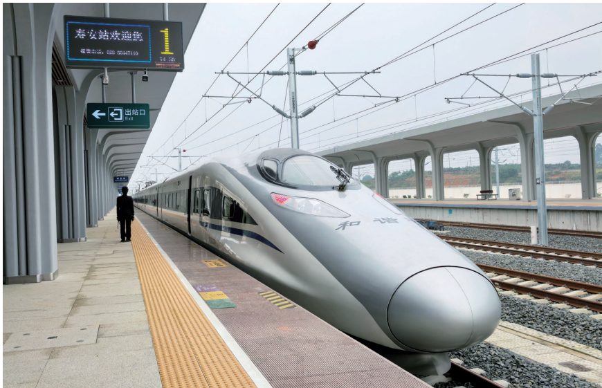
一辆列车停靠在天蒲铁路寿安站站台。中国铁路成都局集团有限公司供图
