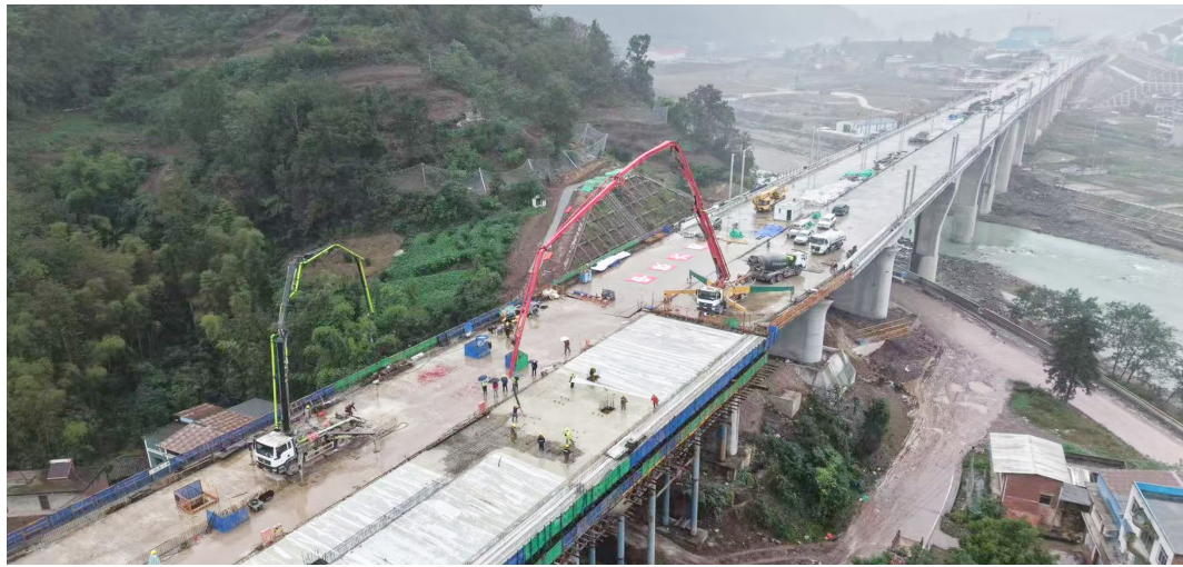
西渝高铁樊吟站2号六线特大桥合龙。
