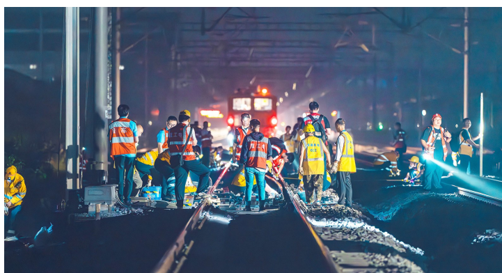
襄渝铁路集中修现场,检修人员开展接触网绝缘子更换作业。
