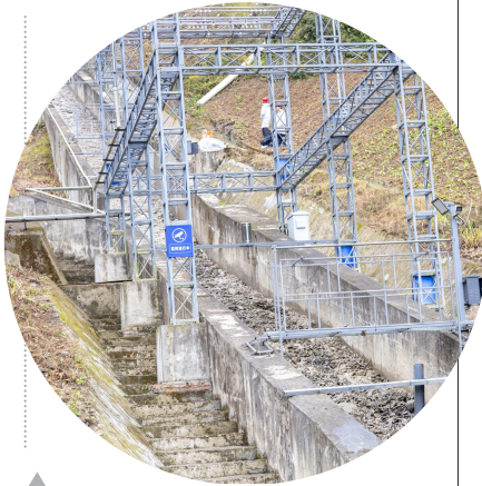
北川大型泥石流野外试验基地建成投用。 图据川观新闻
