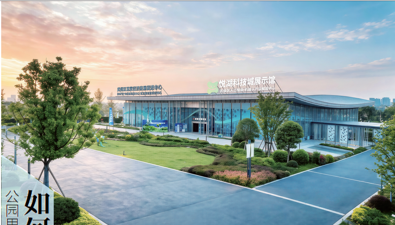
成都市武侯区悦湖科技城展示馆。
