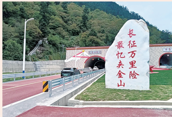
国道351线夹金山隧道宝兴入口。高菲菲 摄
