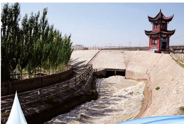
甘肃讨 赖河北干渠 取水口。
