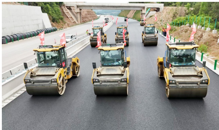
无人碾压施工现场。蜀道集团供图
