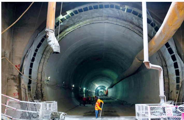
市域(郊)铁路成眉线地下区间全部贯通。成都轨道集团供图
