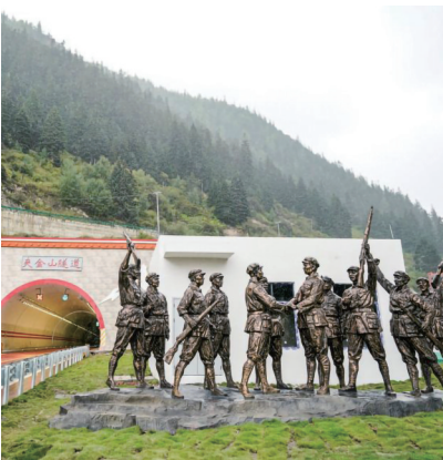
2025年9月28日在阿坝州小金县拍摄的夹金山隧道出口。
