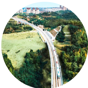
▲ 轨道交通资阳线列车行驶航拍图。图据成都地铁微信公众号
