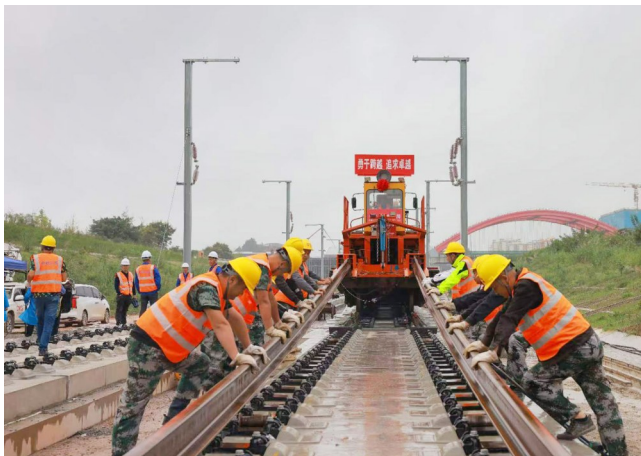
成达万高铁铺轨施工现场。成达万高铁公司供图
